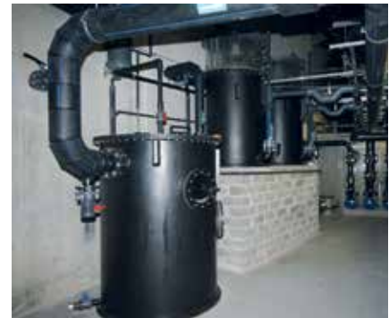
◆ WIDOK NA FILTR BIOLOGICZNY, ODPIENIACZ I POMPY DO AKWARIUM TANGANIKA I MALAWI
