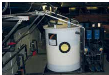
WIDOK NA URZĄDZENIA DO DENITRYFIKACJI DLA REKINARIUM
